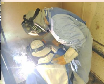
電気溶接職種
