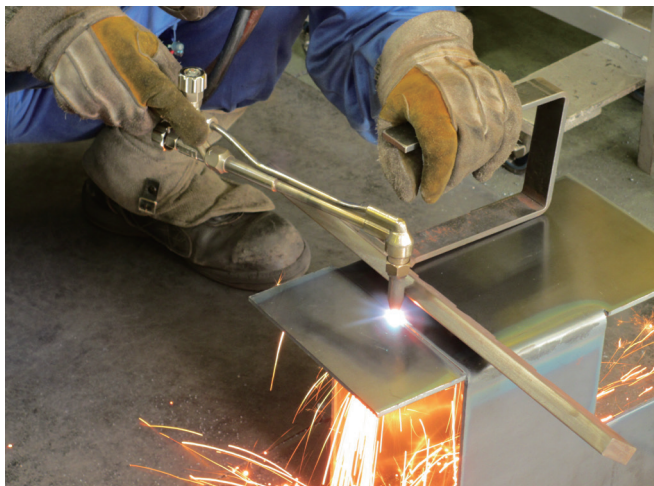
ガス切断作業
